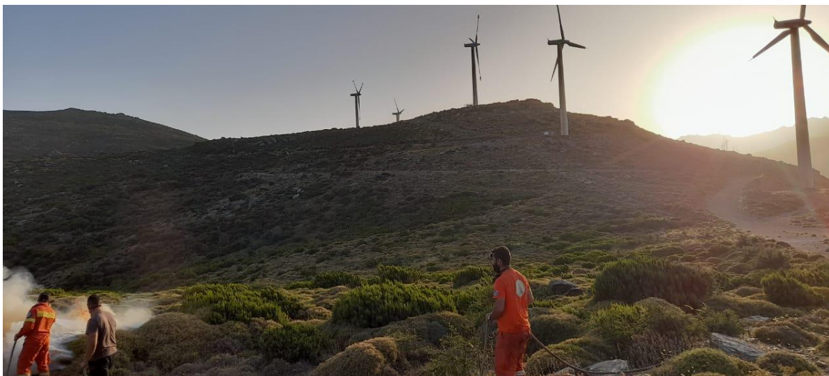
Αιολικό πάρκο από τη Νότια Εύβοια (Παλαιόπυργο) που αποτυπώνει ότι η χάραξη δρόμων για τα αιολικά, υποστήριξε σημαντικά το έργο των πυροσβεστικών δυνάμεων - Ιούλιος 2023
