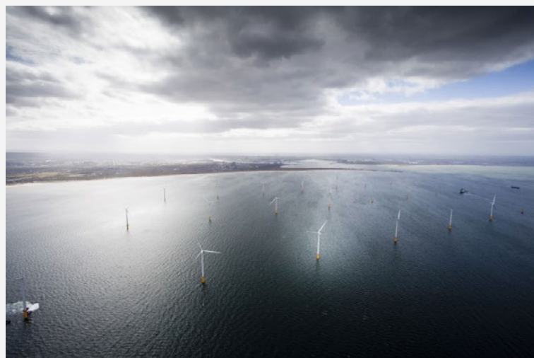
Υπεράκτιο αιολικό πάρκο στο Ηνωμένο Βασίλειο Φωτογραφία: ©EDF-Brown Graham Chapman Brown Photography
